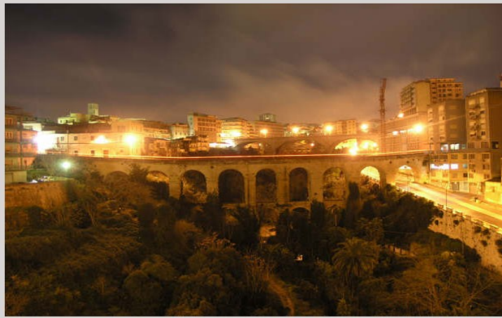
- Ponte Padre Scopetta (Ponte Vecchio) - La foto è stata gentilmente donata dal Sig. Paolo Bonanno
