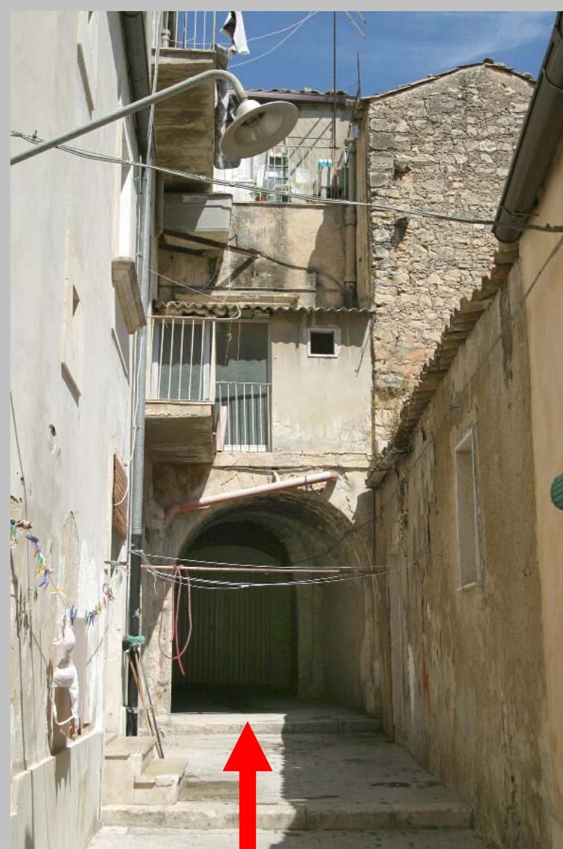
Unità edilizia n. 25 isolato n.89 interessata da intervento di realizzazione sottopasso
